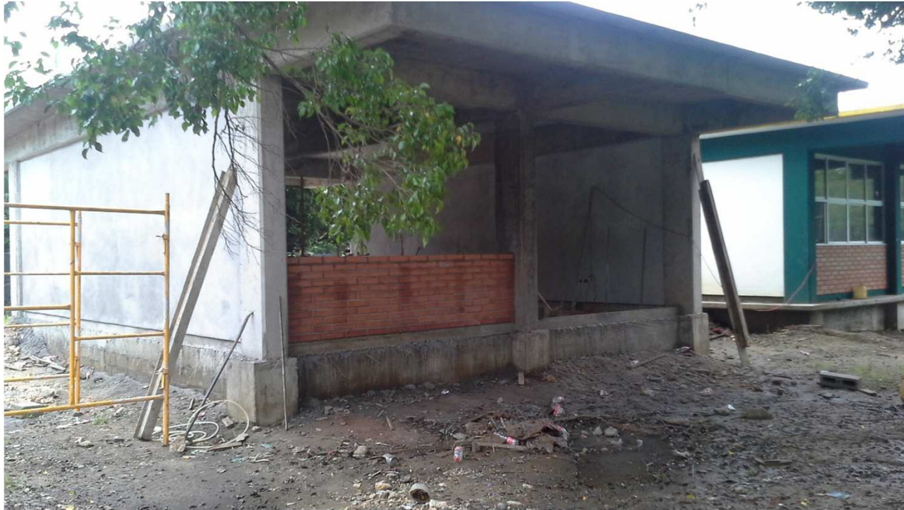
CBTA. 141 AGUA BUENA TAMASOPO, S.L.P. CONSTRUCCION DE UN AULA DIDACTICA ESTRUCTURA U-1C DE DOS ENTREEJES Y OBRAS EXTERIORES.
